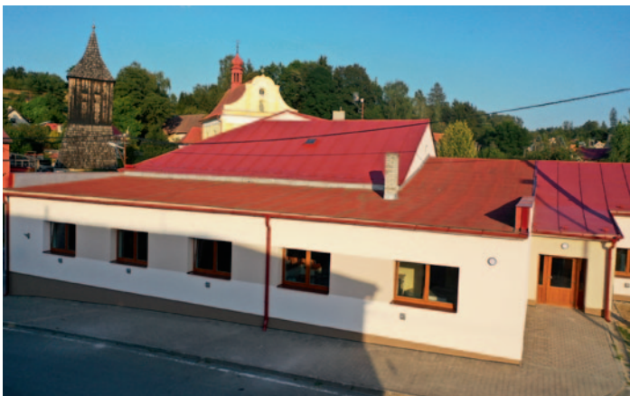
Zateplení budovy Kulturního domu v Horním Studenci
