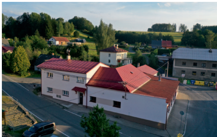
Zateplení bylo provedeno i na restauraci a bytu KD v H. Studenci
